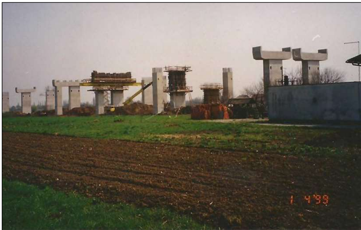
Slika 8. Izgradnja vijadukta "Drežnik" kod Karlovca.
