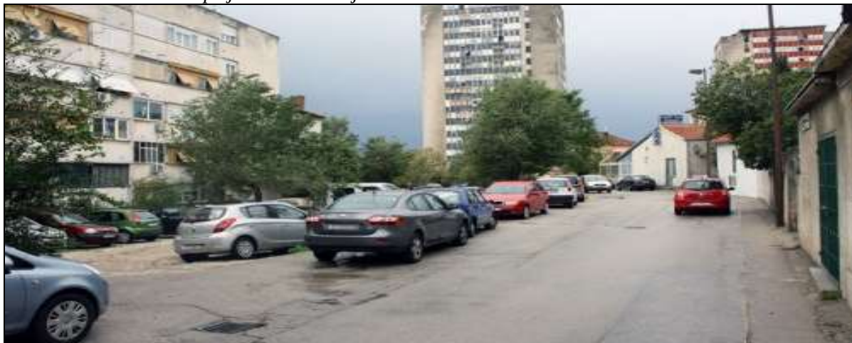
Slika 2. Bosanska ulica prije rekonstrukcije.
