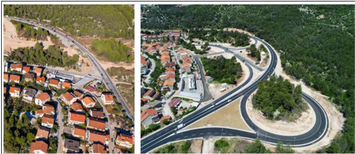
Slika 2. Čvor Rokići (lijevo – prije rekonstrukcije, desno – poslije rekonstrukcije)
