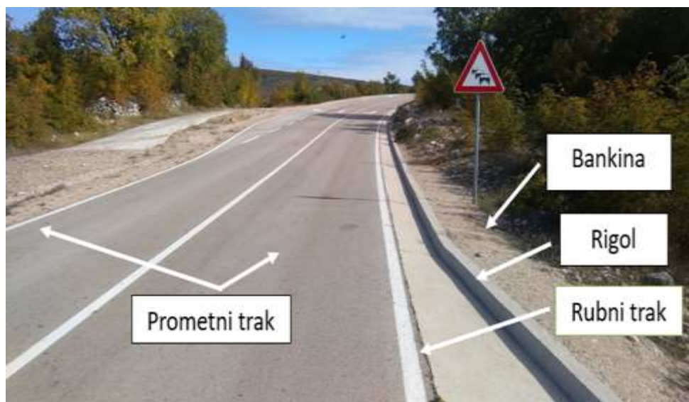
Slika 23. Osnovni elementi poprečnog presjeka ceste
