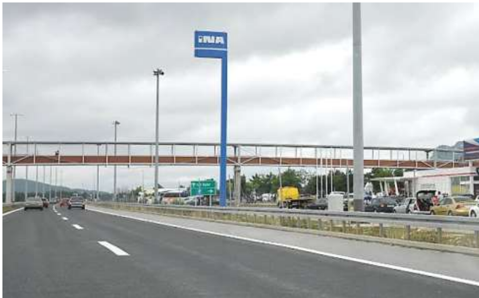
Slika 140. Mostovi za pješake na autocesti između dvaju odmorišta
