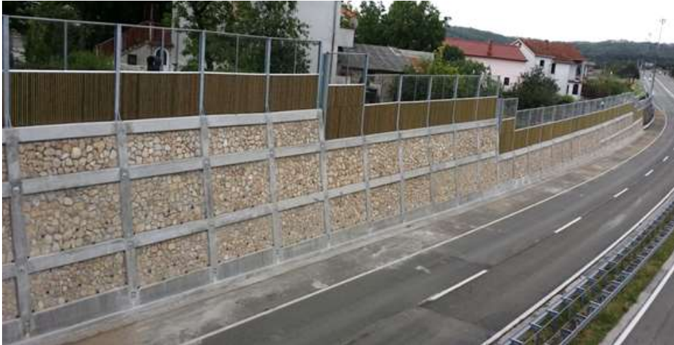
Slika 79. Građevina za zaštitu od buke
