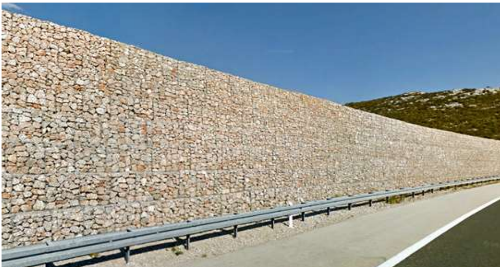
Slika 81. Građevina za zaštitu od vjetra
