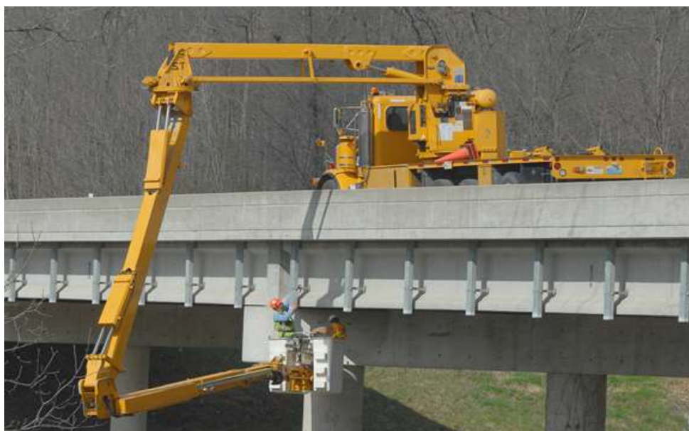
Slika 101. Radovi na održavanju cestovnog objekta
