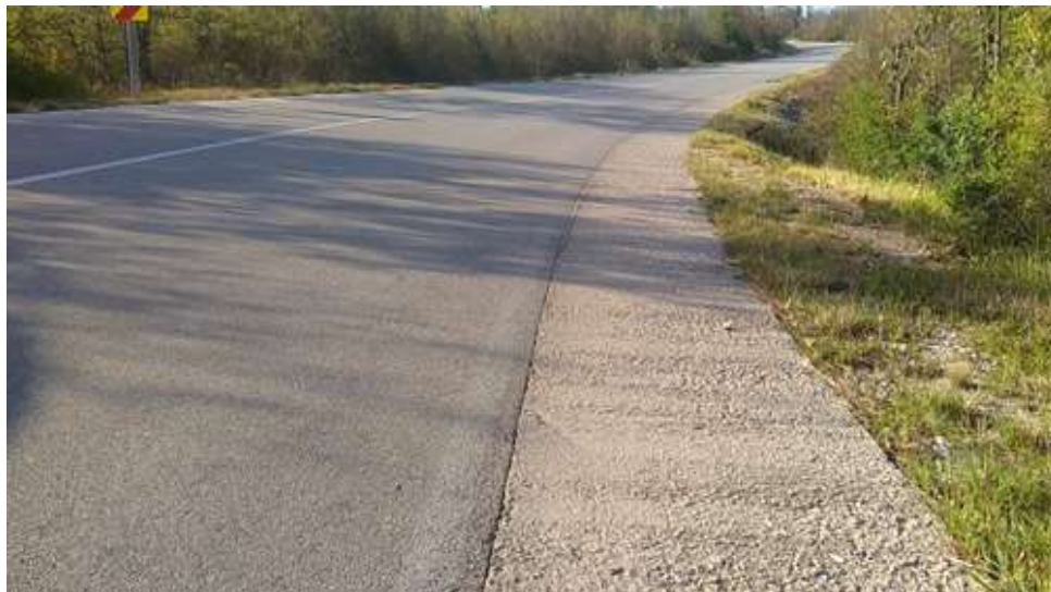
Slika 19. Proširenje kolnika u kružnom luku zbog potrebne bolje preglednosti
