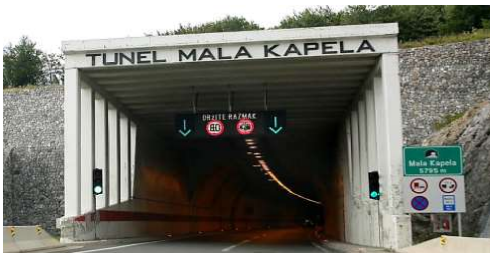
Slika 86. Ulaz u tunel
