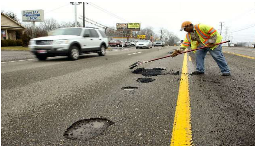
Slika 100. Radovi na prometnoj površini (popravak rupa na kolniku ceste)
