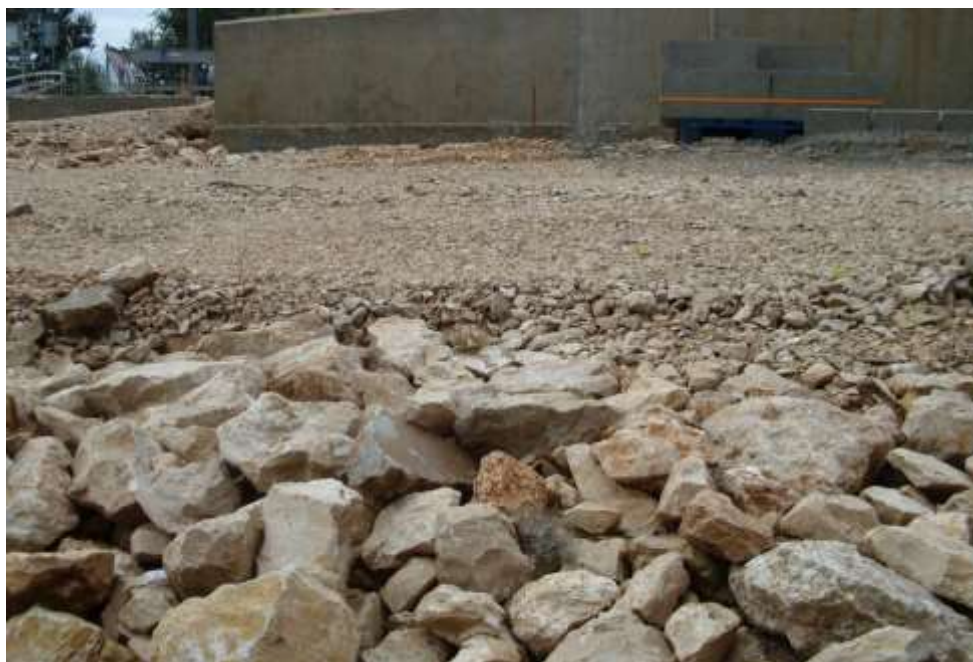
Slika 43. Podloga cestovnog zastora izvedena od dva sloja kamenog materijala različite granulacije
