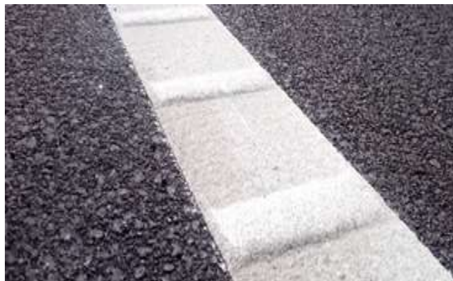
Slika 58. Vibracijska crta za zvučno upozorenje vozačima
