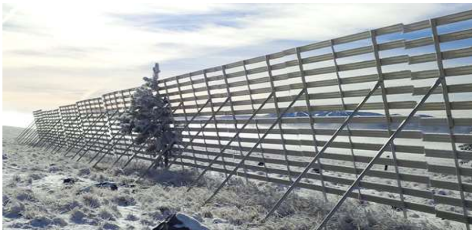
Slika 80. Građevina za zaštitu od snijega
