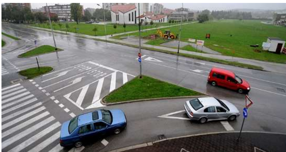
Slika 117. Cestovno raskrižje u jednoj razini u naselju
