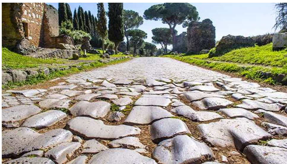
Slika 1. Stara cesta popločana kamenim pločama
