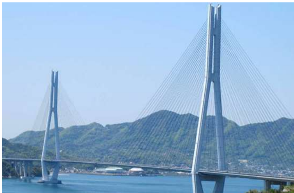
Slika 38. Ovješeni betonski most
