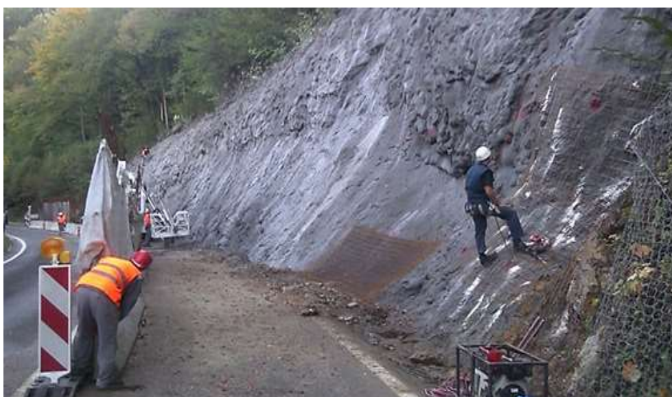
Slika 103. Radovi na sanaciji odrona
