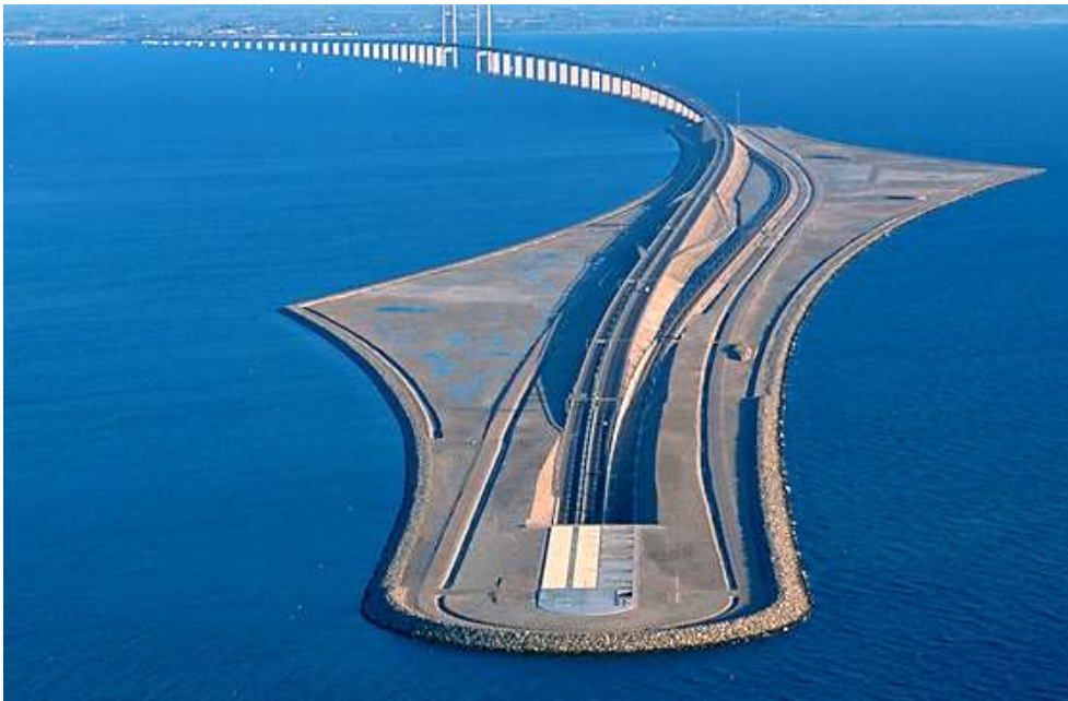
Slika 37. Ulazak u cestovni podvodni tunel u Danskoj
