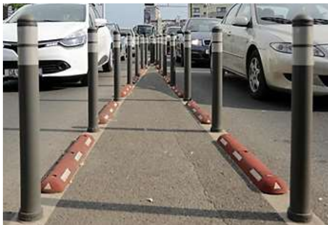
Slika 93. Trajni (fiksirani) stupići za zaprečivanje prolaza i usmjeravanje vozila
