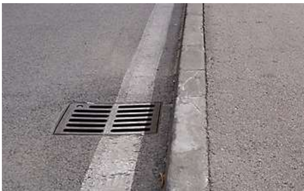
Slika 30. Slivnik s rešetkom uz rub ulice (slivnik je položen ravno u razini kolnika).
