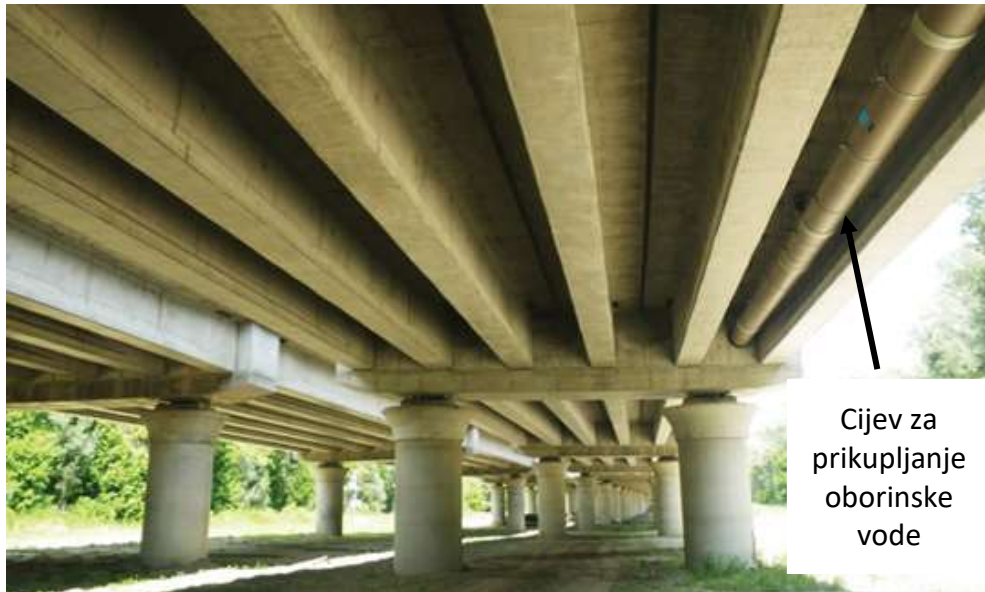
Slika 27. Cijev za prikupljanje oborinske vode s kolnika nadvožnjaka
