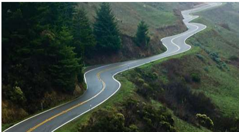
Slika 33. Cesta u zasjeku
