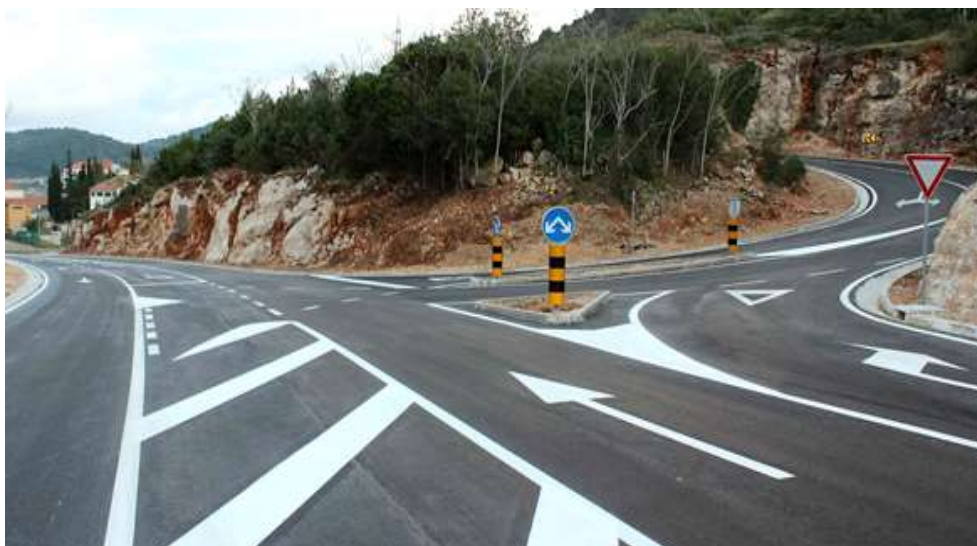
Slika 116. Cestovno raskrižje u jednoj razini izvan naselja
